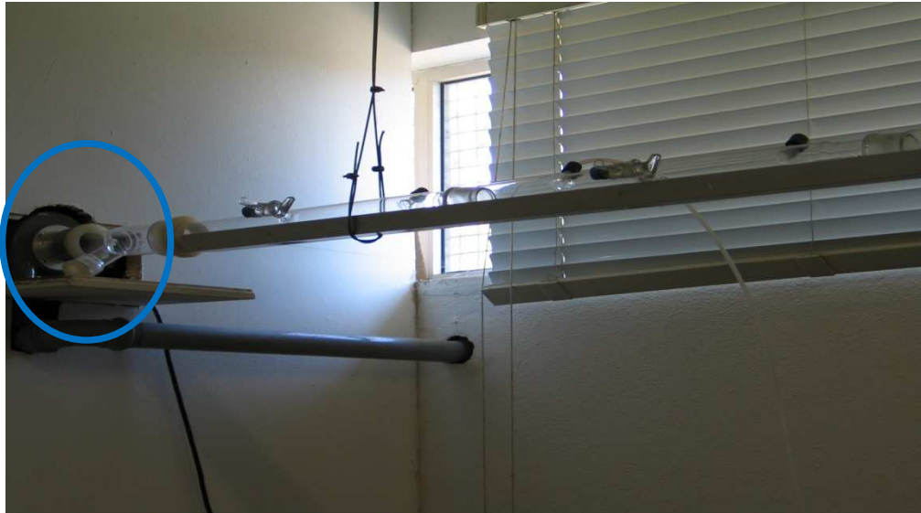
Figura 1 - Foto da bomba colocada a jusante da linha de amostragem ( manifold ). Estação da Qualidade do Ar de Monte Velho. Cortesia da CCDR – Alentejo
