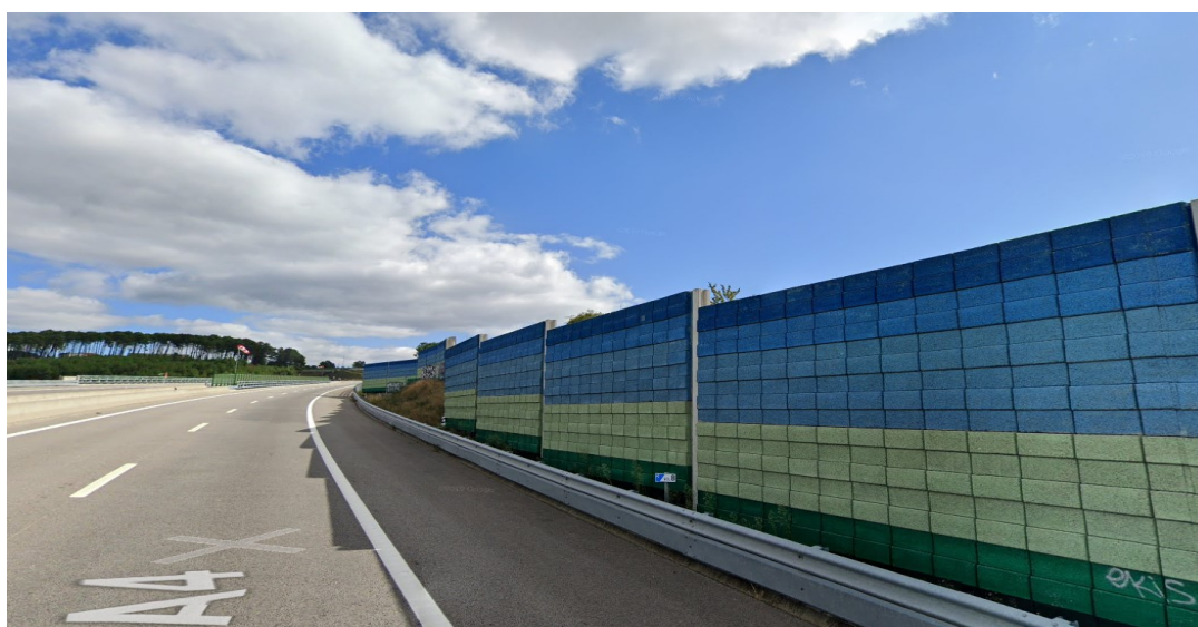
Imagem 3: Barreira de Betão
